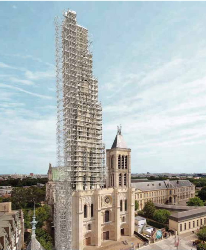
↘ Les grands chantiers
