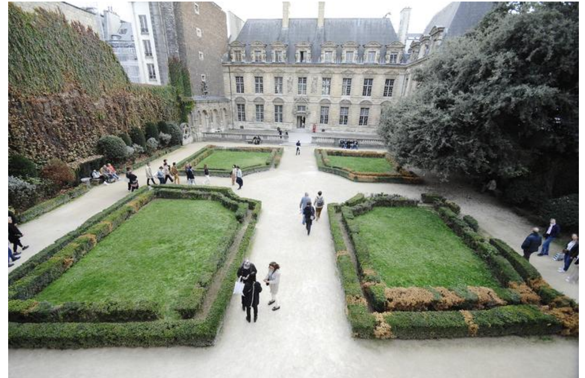
© Benjamin Gavaudo / Centre des monuments nationaux Jardin de l'hôtel de Sully avant chantier. Hiver 2023 : travaux de rénovation.
