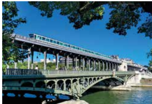
The Bir Hakeim Bridge
